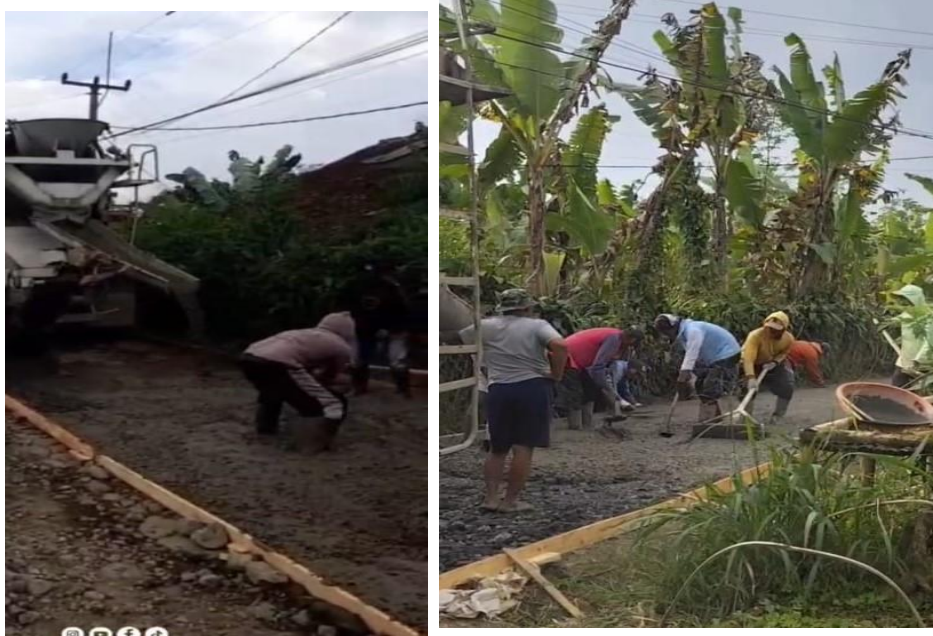
Gambar 1. Kegiatan gotong rotong perbaikan jalan yang dilakukan
